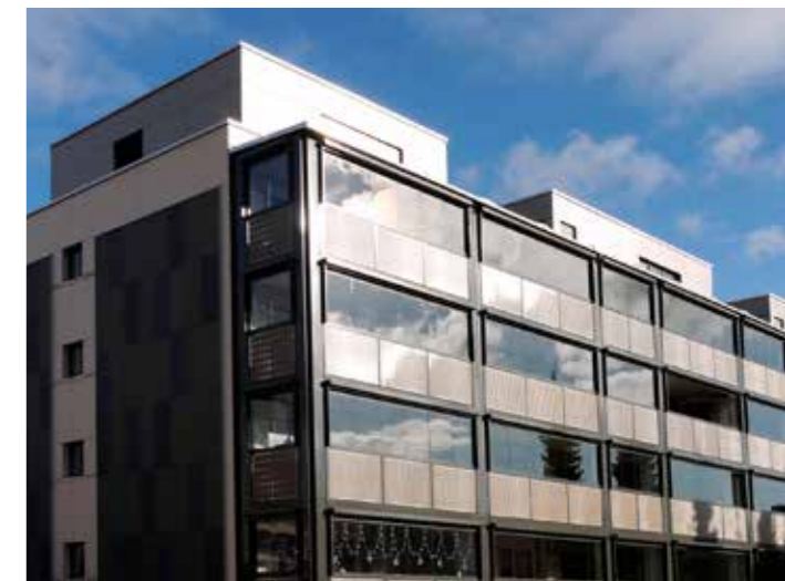
Bij een woongebouw in Bern (Zwitserland) heeft de VvE als verduurzamingsmaatregel gekozen voor Balco-balkonbeglazing met geïntegreerde zonnepanelen.
