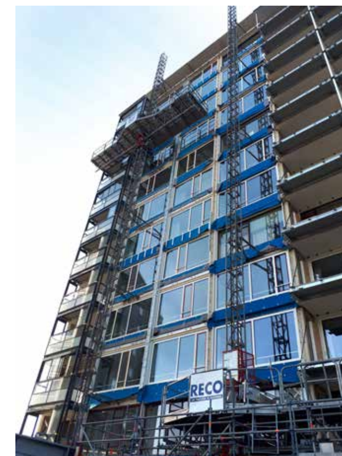
De balkons zijn verbreed en het probleem van de koudebruggen is aangepakt.
